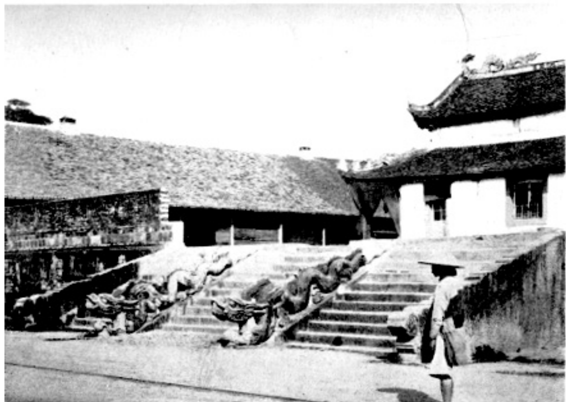
Planche XXVIII. — Escalier de la Pagode royale, dans la Citadelle de Hanoi, en 1886.
